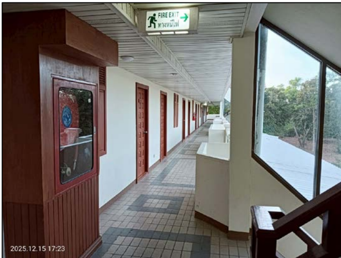
บริเวณที่มีการติดตั้งป้ายบอกทางหนีไฟ ตู้เก็บสายฉีดน้ำดับเพลิง และถังดับเพลิงเคมีแบบมือถือในพื้นที่โครงการ
